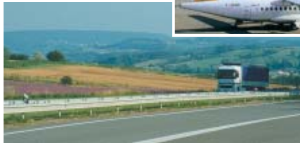
4 voies : Sortie Lons-le-Saunier nord.
